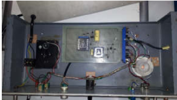
Figura 2: interno dell'amplificatore per termocoppie
