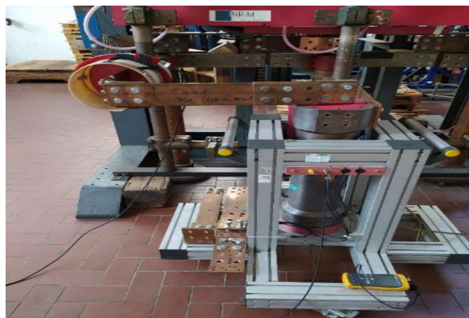
Figura 2 – Shunt collegato all'impianto di generazione di corto circuito
